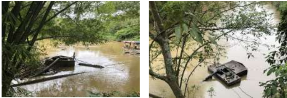
Gambar 6. 1 Intake di Sungai Balangan
