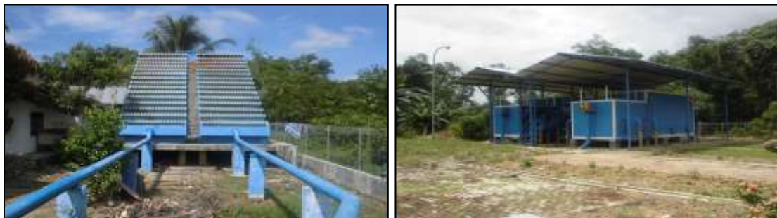
Gambar 3. 2 Kiri Unit pengolahan Aerasi (SPAM IKK Batu Mandi) dan Kanan Unit Pengolahan Lenngkap IPA Paket Konstruksi Baja (Paringin Selatan)
