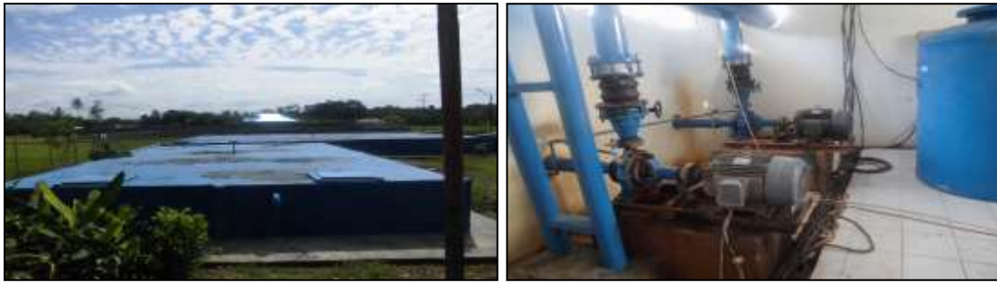
Gambar 3. 3 Kiri Unit penampungan (reservoir distribusi) konstruksi Beton dan Kanan Unit Perpompaaan untuk system Distribusi
