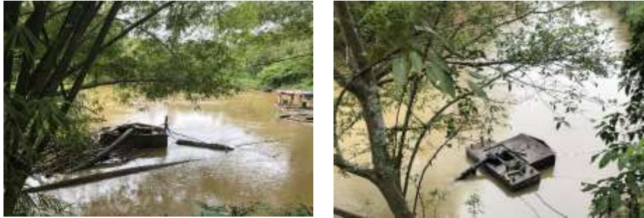
Gambar 6. 1 Intake di Sungai Balangan
