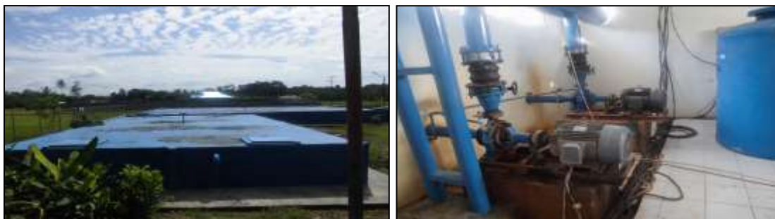
Gambar 3. 3 Kiri Unit penampungan (reservoir distribusi) konstruksi Beton dan Kanan Unit Perpompaan untuk system Distribusi
